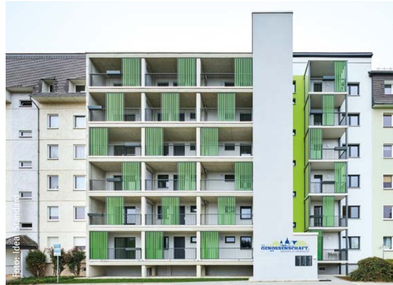
Plattenbau in Freiberg nach seiner umfassenden Sanierung.
